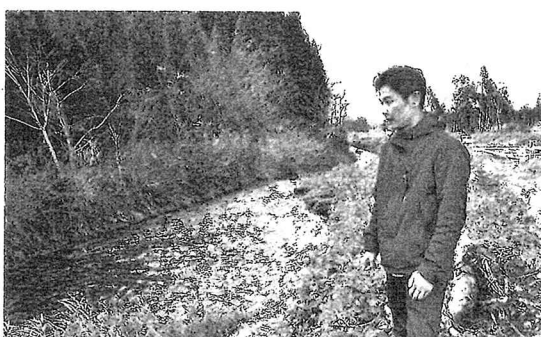
小水力発電所の工事現場に立つ西村社長。「川の水が澄んでいると流量が安定し、効率的に発電できる」と話す一鹿角市花輪字近江谷地
