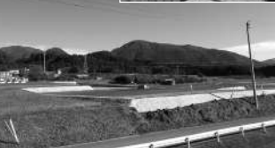
多目的屋内運動場建設の様子
