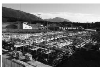
実習棟・講堂建設の様子
